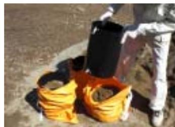
シートを真上に引抜きます。(簡単に引抜けます)口を縛り土のうの完成です。
