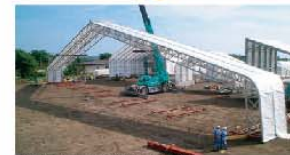
軒下のフレームをつなぎ再び吊上げ
