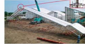
クレーンで吊り上げ切妻型に
